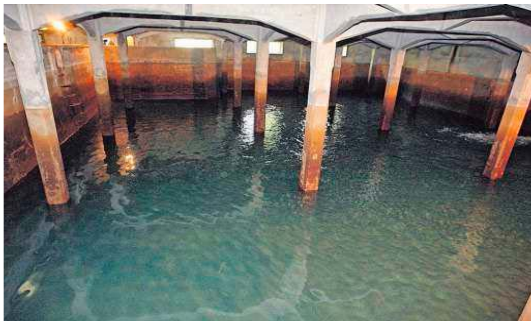
Interior de los depósitos de San Vicente, que en total almacenan 5.100 metros cúbicos. ALBERTO LÓPEZ
